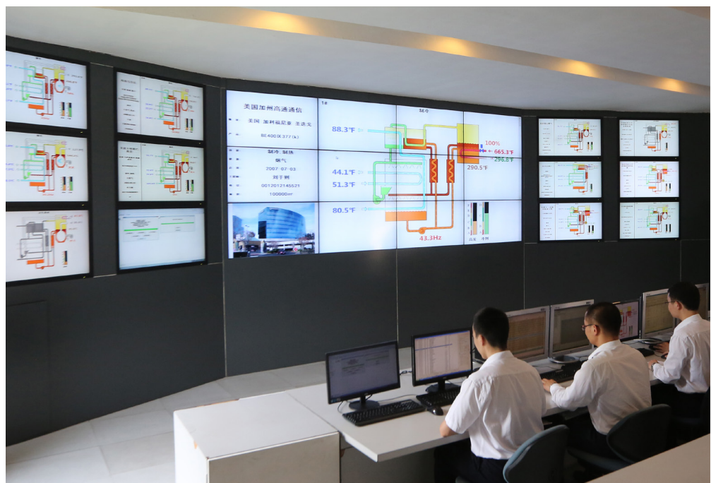
远大非电空调全球联网监控中心 该系统始设于1996年被称为“互联网+”鼻祖
