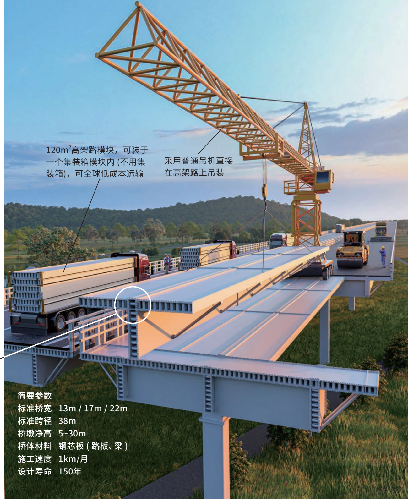
路板、梁材料：钢芯板
