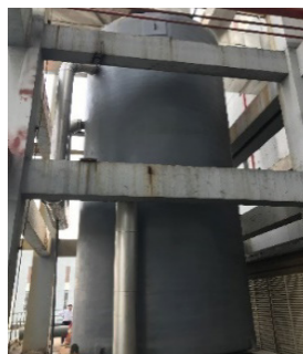
直接接触式 (适配70t燃气锅炉) (Φ4m*14m)
