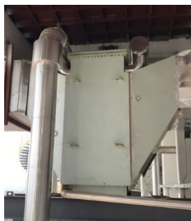
间接接触式 (适配100t燃气锅炉) (2.8m*3.6m*3.45m)
